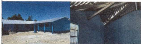
Foto 6: Pintura en muros exteriores e interiores
